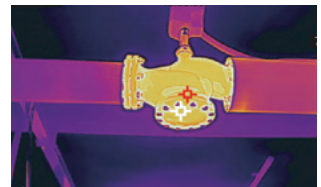
HVAC 유지 보수
